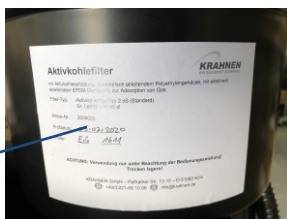
Špecifikácia aplikovaného AK filtra
